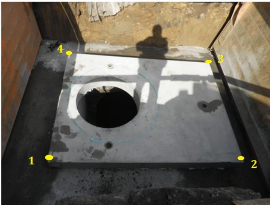
Bod č. 1,2,3,4 Roh vnějšího podzemní obvod šachty
